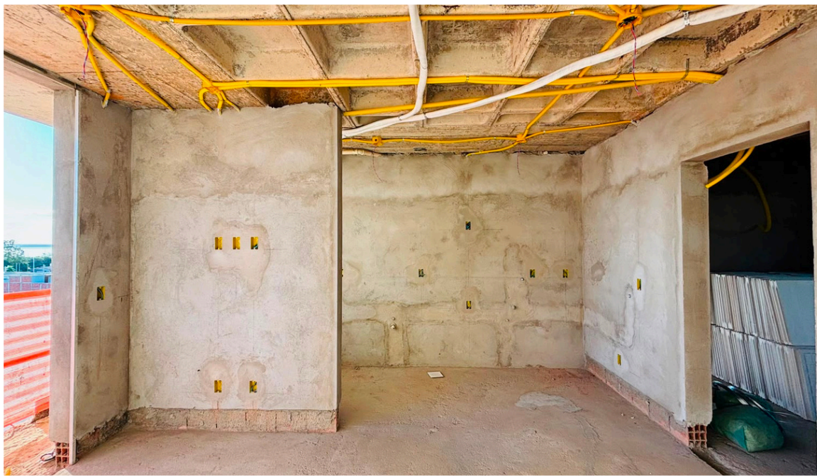
Execução de Reboco Interno e Instalações
