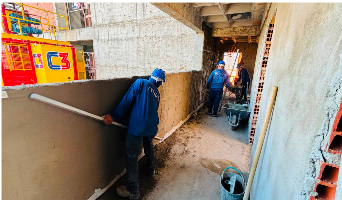
Vista Circulação Interna - Execução de Reboco
